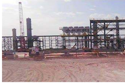
RÖNESANS ENDÜSTRİ TESİSLERİ İNŞAAT SANAYİ VE TİCARET A.Ş.
